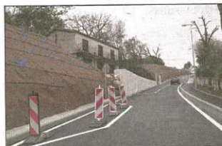
Une écluse avec priorité à la montée est censée casser la vitesse.
