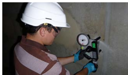
→ Essai d'adhérence au dynamomètre de traction
