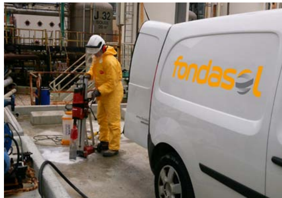
→ Prélèvement de béton à la carotteuse pour analyses en laboratoire
