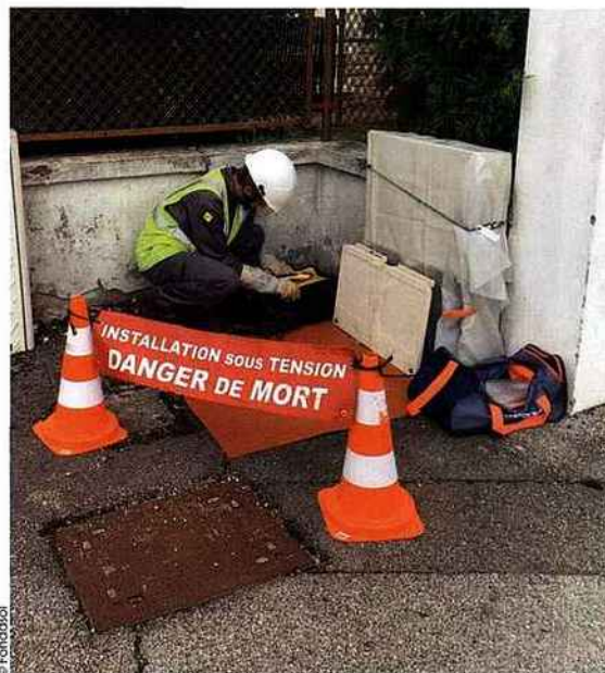
Signalisation lors d'une intervention.
