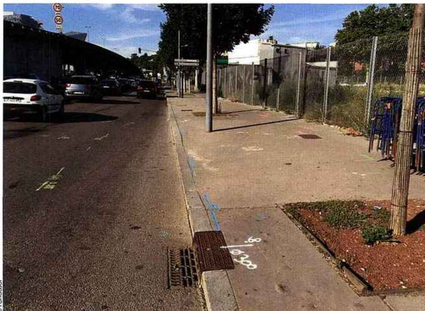
À droite sur le trottoir, marquage au sol après détection.
