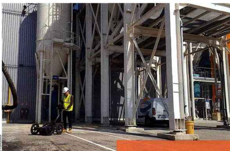
Lors d'une phase de détection.
