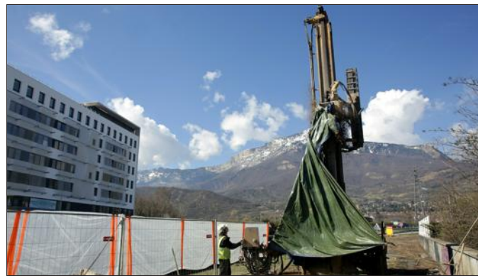
Fondasol (700 salariés en France) possède une centaine de foreuses mais une seule Sonic, qui fonctionne par vibrations soniques, utilisée au Rondeau (à gauche). « C'est la Rolls Royce des foreuses : sa tête vibre à une certaine fréquence, ça crée un anneau de sol liquéfié autour de la tête de forage. C'est quatre fois plus rapide qu'une foreuse hydraulique mais ça consomme énormément d'eau, il faut donc avoir une citerne avec », dit Bénédicte Saintier. Photo Le DL/J.-B.V.
