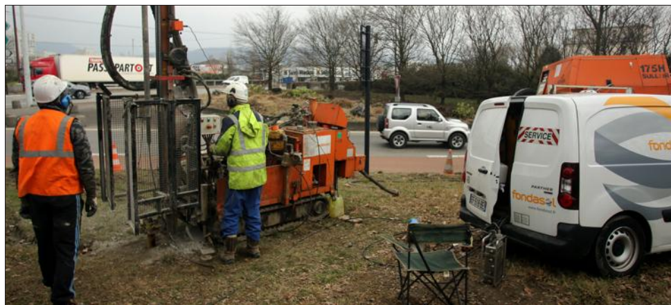
Ici, une équipe de Fondasol intervenant avec une foreuse pneumatique, qui fait des forages pressiométriques. Au total, environ 20 forages différents ont ainsi été réalisés au Rondeau. Photo Le DL/Jean-Benoît VIGNY
