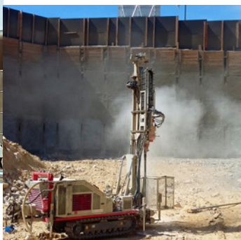
→ Construction du complexe mixte urbain Infinity (Luxembourg-Ville). Investigations géotechniques, études géotechniques G2 AVP, supervision géotechnique d'exécution G4
